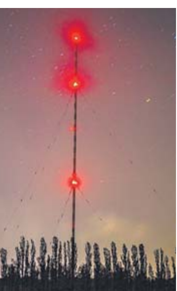
Der 153 Meter hohe Mittelwellen-Funkturm in Wilsdruff. Heute ist er ein technisches Denkmal. FOTO: REALNR/WIKIPEDIA
